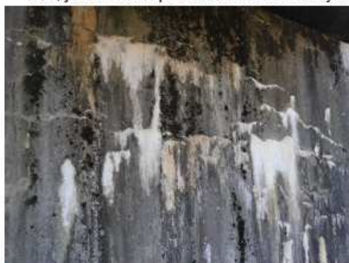
foto č. 15: O 01 úložný práh střed - trhliny s výluzy pojiva
