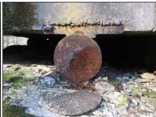
foto č. 14: P. HL. N. nad O 02 pravé ložisko - odpadnutí poloviny tloušťky okalku
