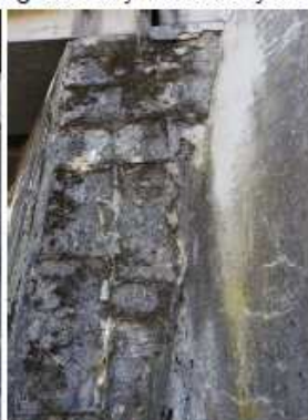
foto č. 16: O 01 zleva - opadaná omítka, degradovaný beton
