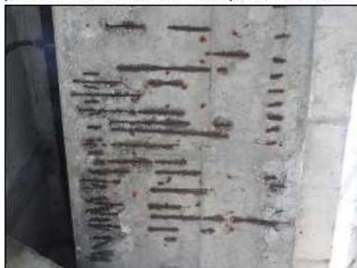
foto č. 1: P. HL. N. u O 02 - degradace betonu, obnaž. beton. výztuž foto č. 2: P. HL. N. nad O 02 - degradace betonu, obnažená výztuž
