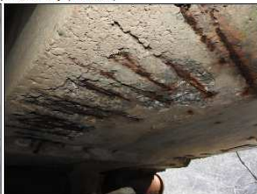
foto č. 1: P. HL. N. u O 02 - degradace betonu, obnaž. beton. výztuž foto č. 2: P. HL. N. nad O 02 - degradace betonu, obnažená výztuž
