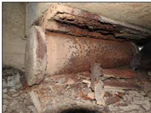
foto č. 13 P. HL. N. nad O 02 - degradace ložisek, celková koroze
